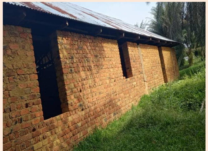
Le service de la pédiatrie en construction
