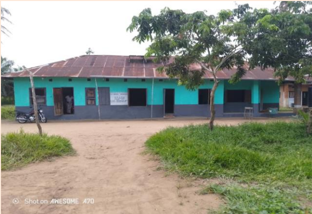
Après la réfection
