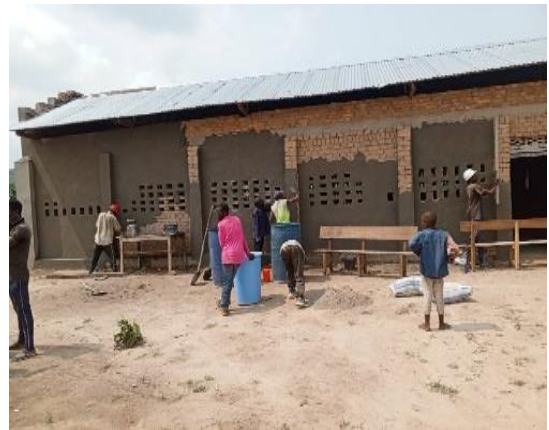
Travaux de finissage
