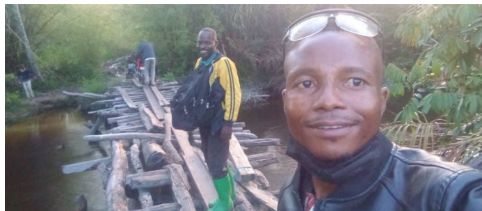
Pont entre Kabinda et Mitombe
